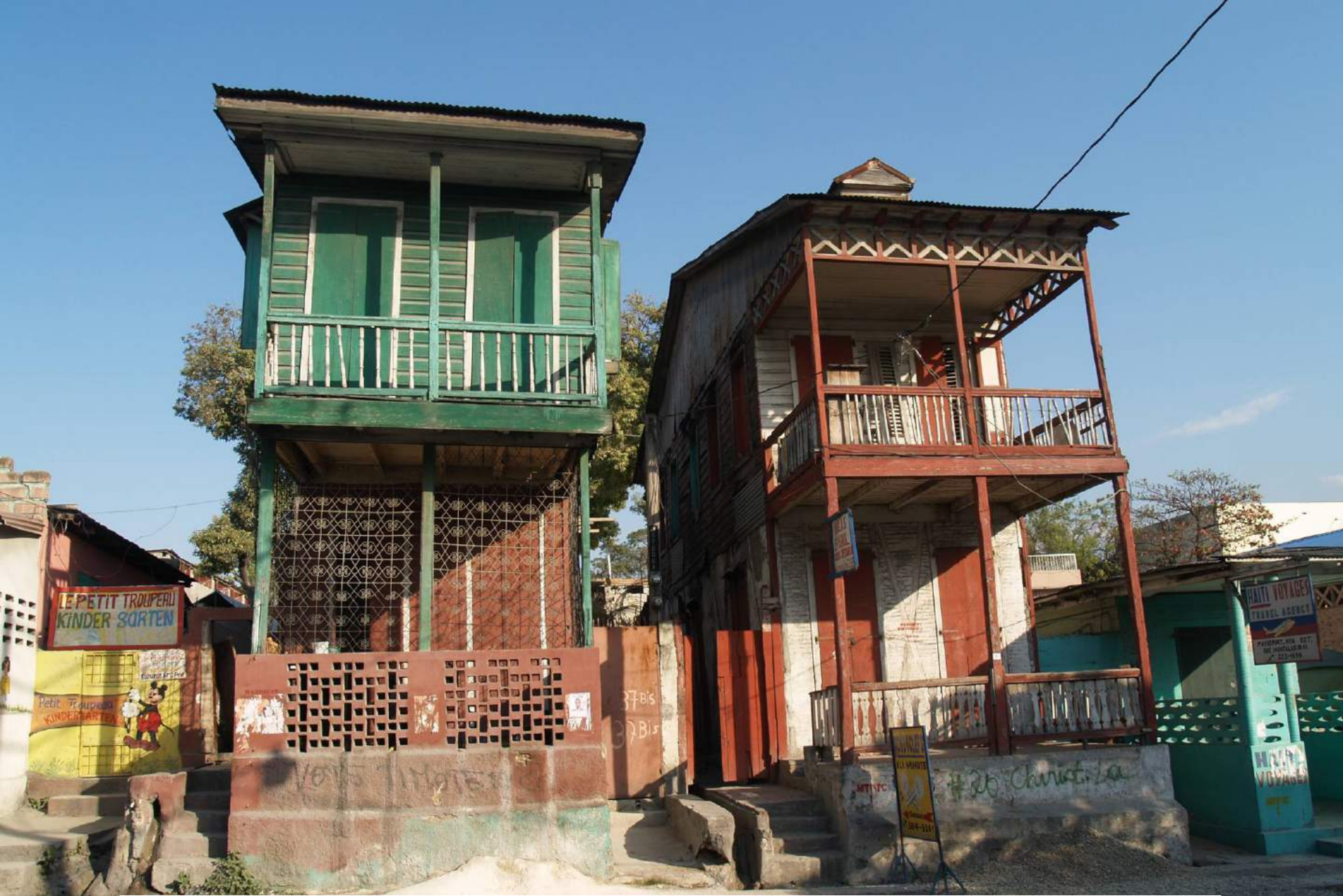
Casa con segundo piso en madera: técnica muy buena y segura
