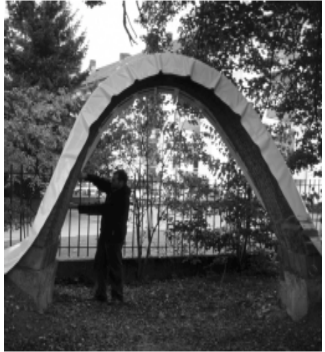
15-8 and 15-9 E a r t h q u a k e r e s i s t a n t v a u l t r e i n f o r c e d w i t h b a m b o o F E B , K a s s e l , 2 0 0 1
