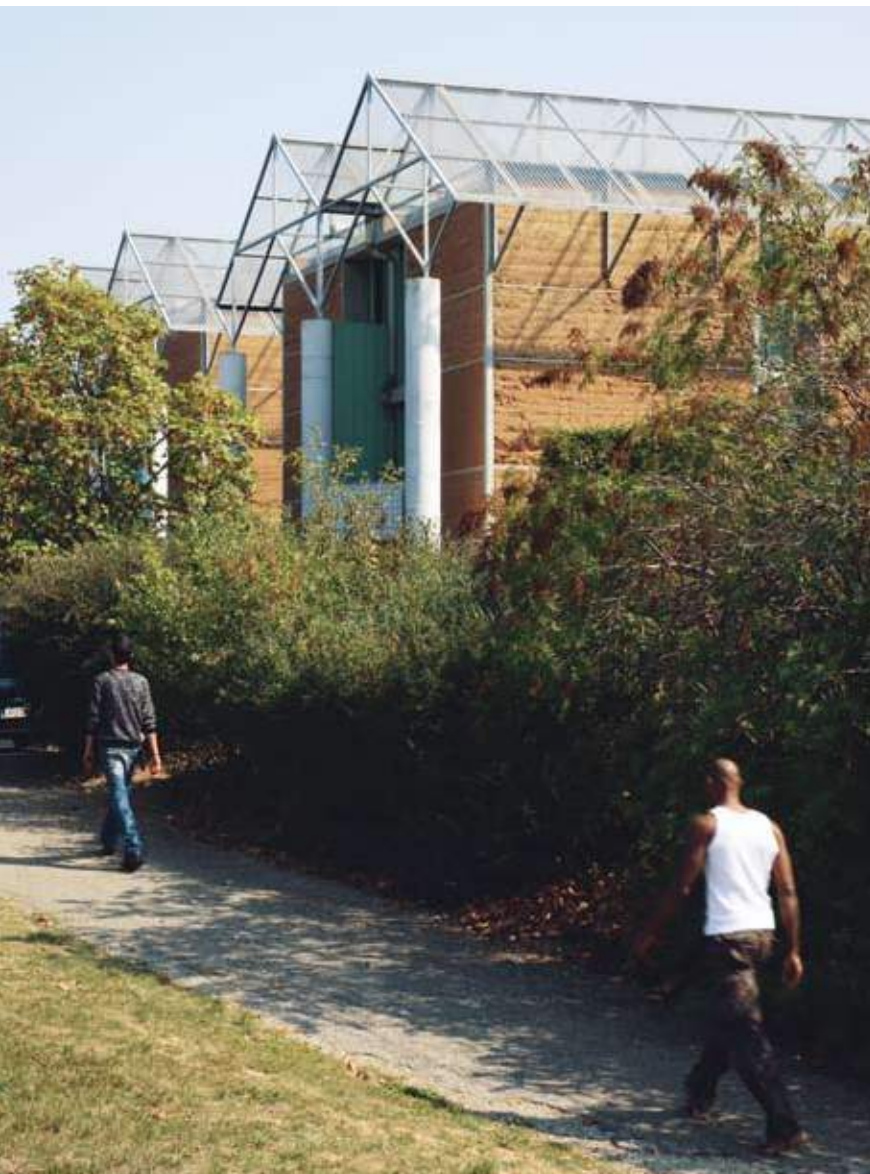
Le bâtiment des architectes Gilles Perraudin et Françoise-Hélène Jourda reprend le principe des hangars agricoles alentour. Sa compacité associée à un mur en pisé garantit un niveau de déperdition thermique minimal.
